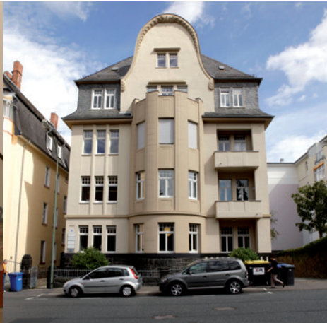
Friedrichstraße 17, Giessen – denkmalgerechte Sanierung in 2008 mit Projektsteuerung durch Kirchmann Gruppe
